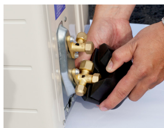
Montering af varmeisolering
