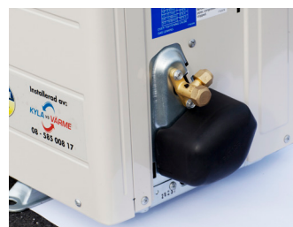
Monteret varmeisolering
